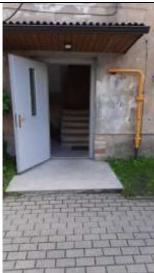
Kāpņu telpas ārdurvis
